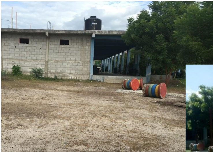
Construcción de Salón de Usos Múltiples
