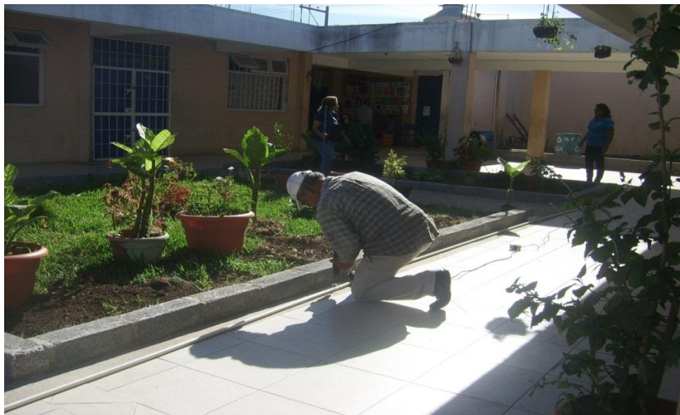
El señor Manuel Arturo Ramírez Cobar, Perforando los tubos para conectar mangueras de riego por goteo en el INEB Santa Isabel,II.
