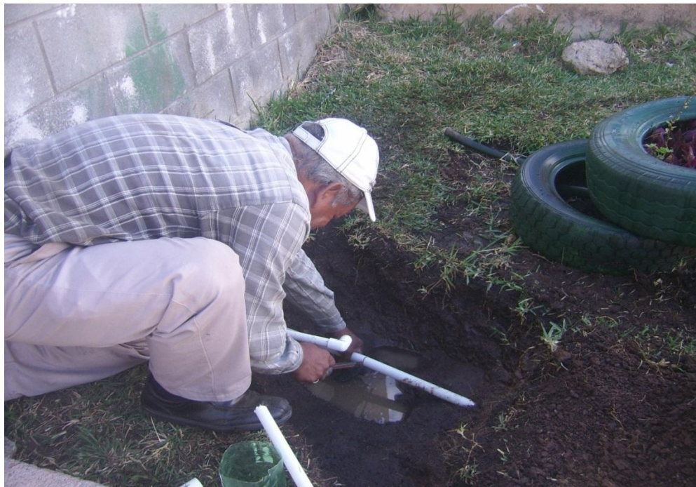
Realizando conexiones en la tubería para el riego por goteo.
