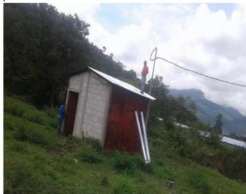
Foto 09 captada por: Reyna Ixpatá, cambio de lámina al techado del pozo.
