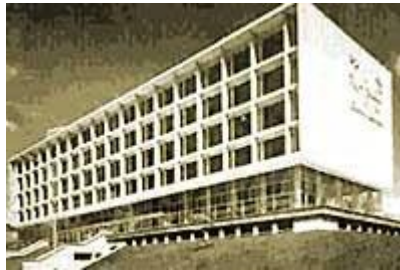
Vista del Palacio Municipal meses después de su inauguración.
