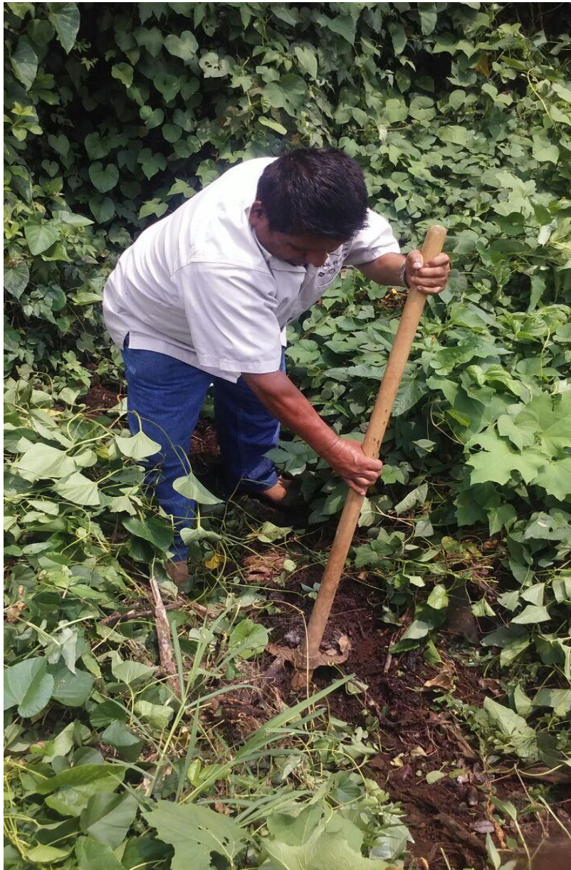
Epesista, apoyando en la jornada de limpieza de cunetas, realizada en Cantón Candelaria Ayutía.
