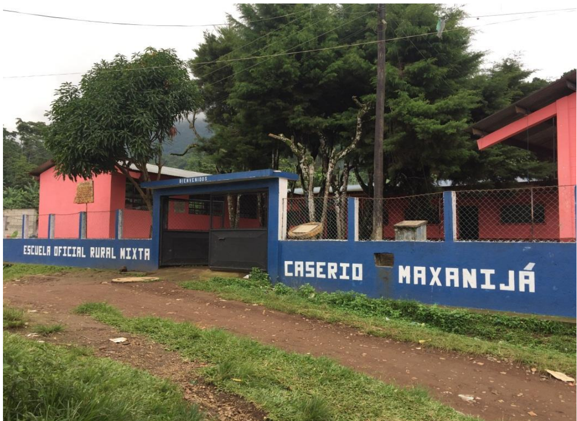
Foto: Edificio de la Escuela Oficial Rural Mixta Caserío Maxanijá.
