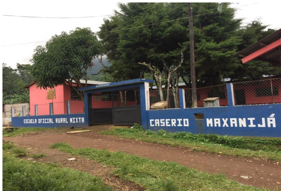
Foto. Ingreso principal del edificio escolar, Caserío Maxanijá.
