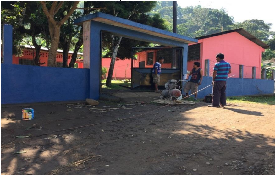
Foto realizando la reparación del portón
