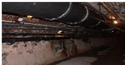
Las redes de alcantarillado son estructuras hidráulicas que funcionan a presión atmosférica, por gravedad. Sólo muy raramente, y por tramos breves, están constituidos por tuberías que trabajan bajo presión o por vacío. Normalmente están constituidas por conductos de sección circular, oval o compuesta, la mayoría de las veces enterrados bajo las vías públicas.<sup>13</sup>
