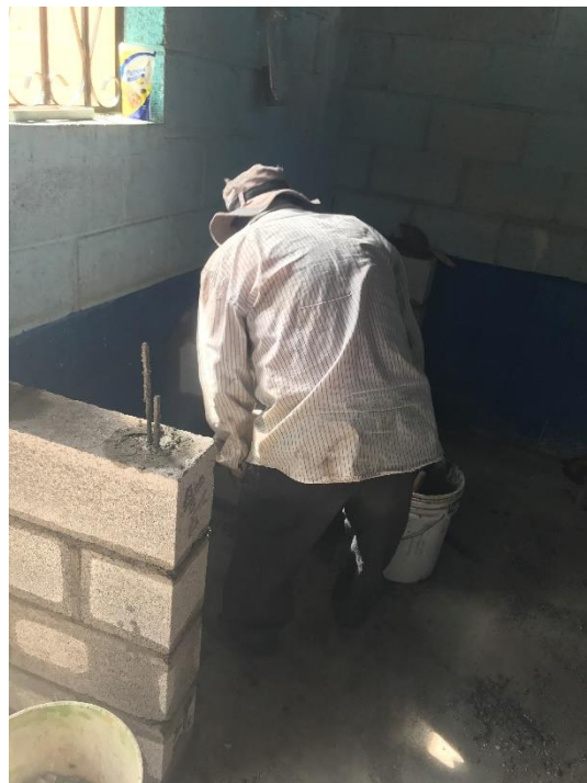
Levantado de pared para el gabinete. Fuente: (Fotografía de Mayra Mejía) Archivo personal.
