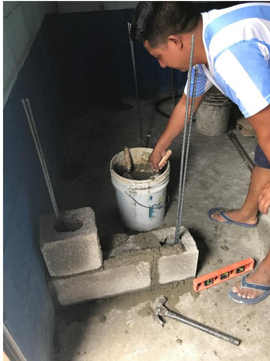
Levantado de pared para el gabinete. Fuente: (Fotografía de Mayra Mejía) Archivo personal.
