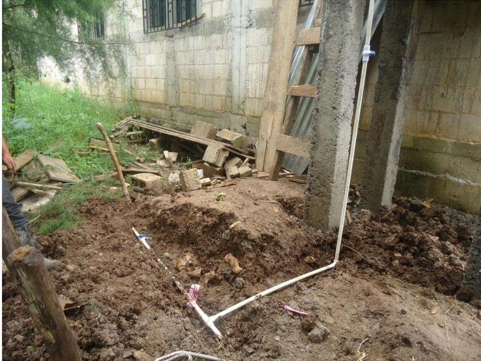
CONEXIÓN DE UN CODO PARA RECEPCIONAR AGUA PLUVIAL
