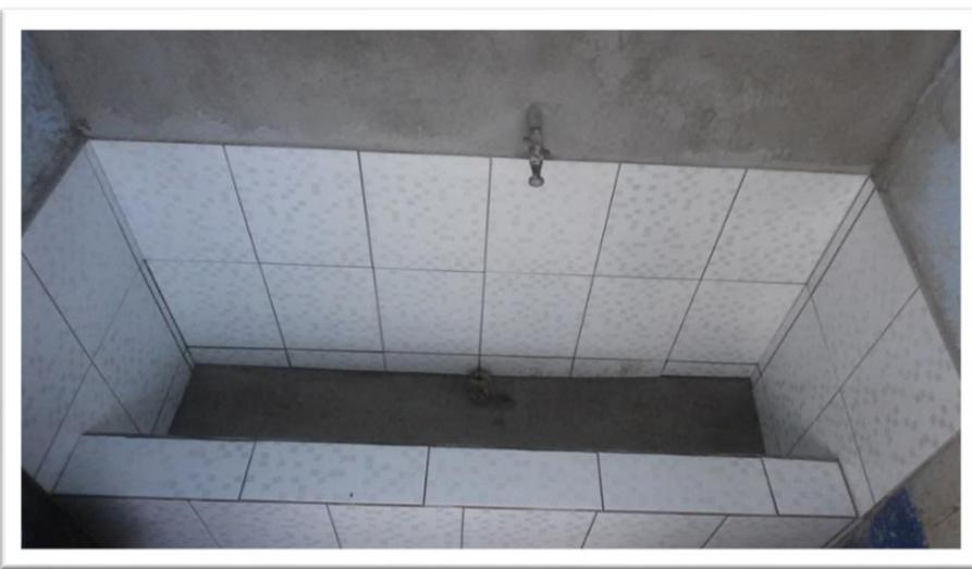
**Ilustración 8. Foto epesista: colocación de azulejo ya finalizado.**
