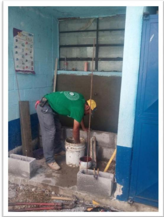
**Ilustración 4 .Foto epesista: repello de paredes.**
