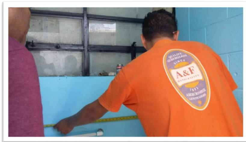
**Ilustración 17. Foto epesista: personal de la vidriería en la toma de medidas de la parte interior del mingitorio para la división del mismo.**
