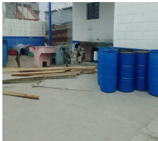
Fotografía No. 31: Materiales. Fuente: Epesista.
