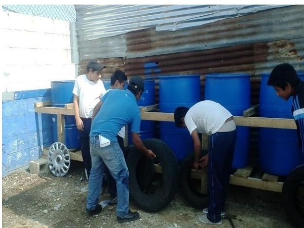
Fotografía No. 34: Integración del tren de reciclaje Fuente: Estudiantes y epesista.
