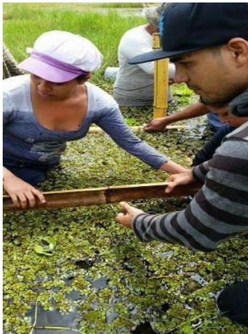
Se amarran con pita, mitades de bambú de 1m cada uno en el exterior de los 4 trozos de bambú sembrados anteriormente. Se repite este proceso hasta que se sobrepase el agua, luego estas se rellena con tierra, monte y trozos de palos, hasta llegar a la superficie y poder sembrar los propágulos de mangle rojo.
