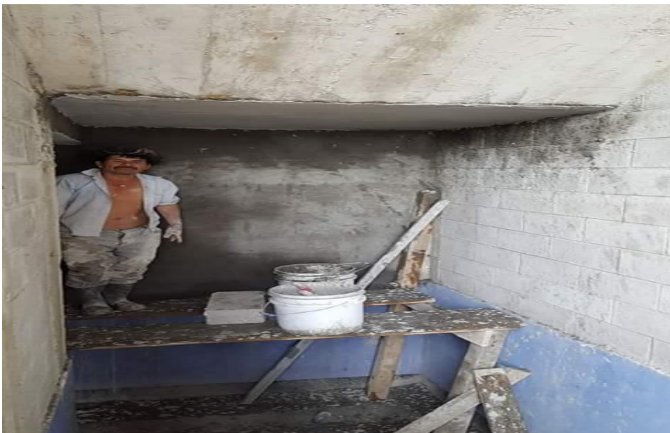
Acabados del segundo y tercer nivel
