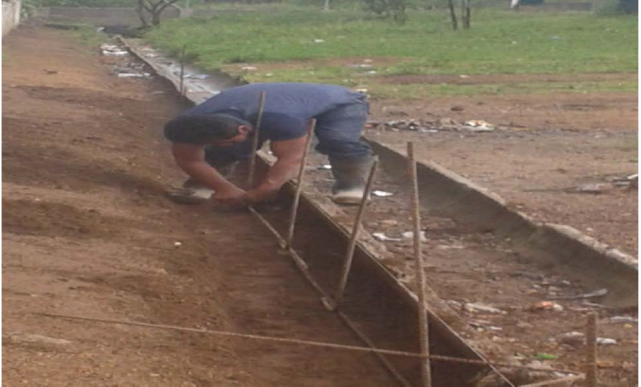
Albañil preparando las varillas para darle soporte a la jardinera
