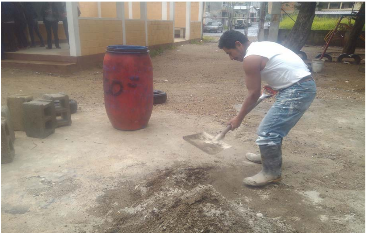
Albañil preparando la mezcla para iniciar con la fundición .
