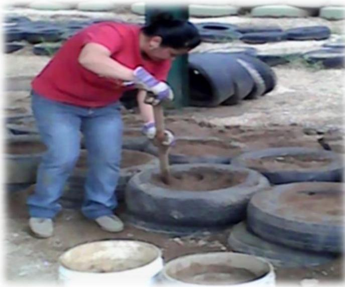
Proceso de relleno de llantas con tierra arena y cemento, se apelmazaron los tres elementos, luego se rego para poner encima una plancha de cemento.
