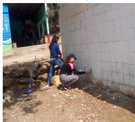
Alumnos caliendo el muro exterior.
