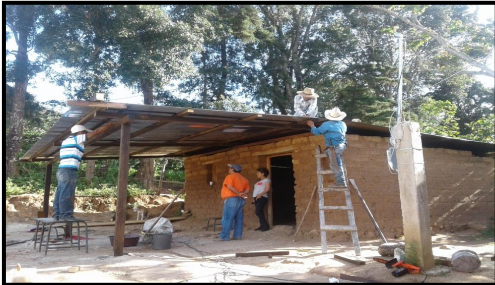
Directora de la escuela observando la construcción de la galera. Albañil, peones y un miembro de la junta de padres de familia clavando la lámina en la galera.
