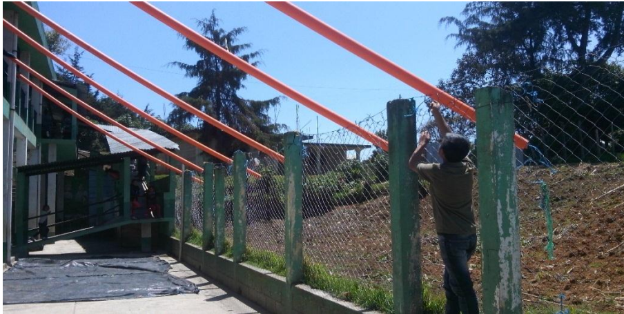
Estudiante instalando techo improvisado para área de evento educativo
