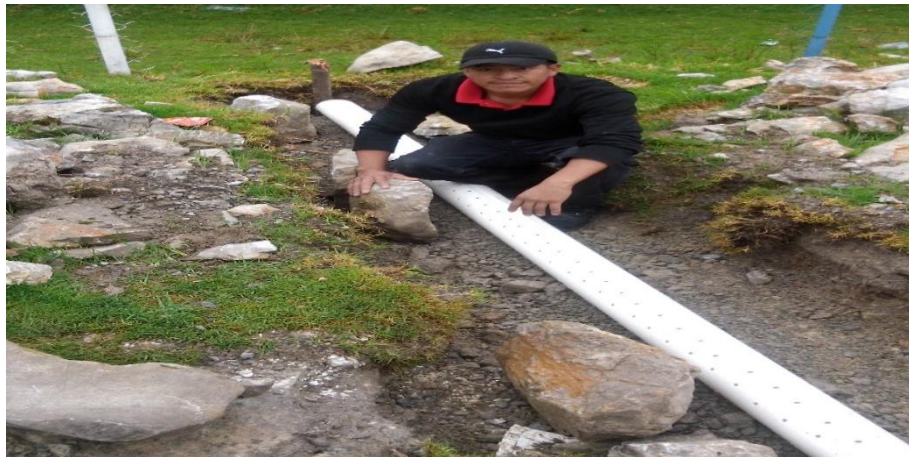
Epesista coadyuvando a instalación de tubería para drenaje
