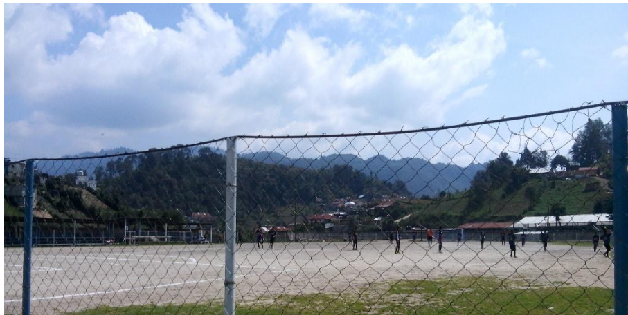
Estadio municipal antes de la ejecución del voluntariado
