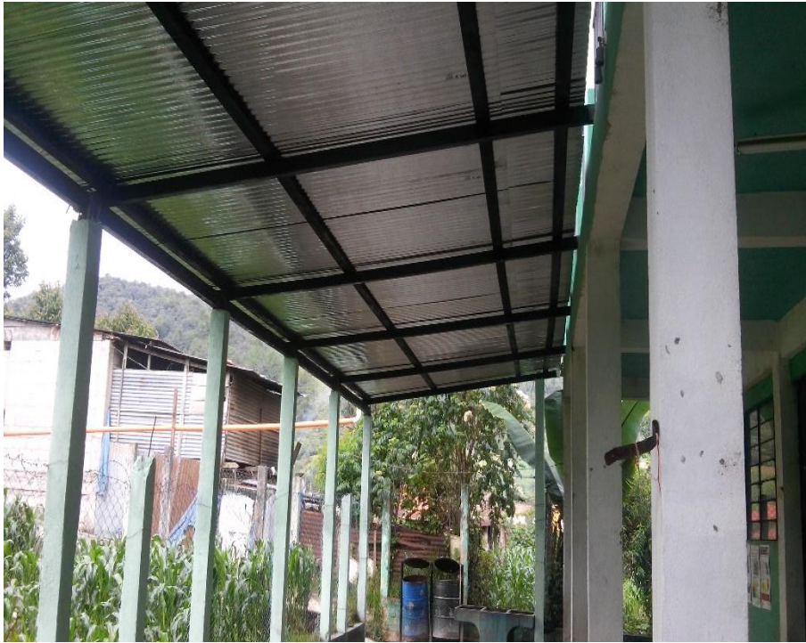
Remozamiento de área de evento educativa finalizada
