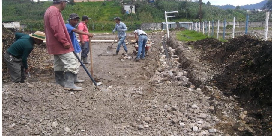
Mano de obra no calificada realizando drenaje tipo francés
