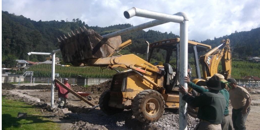
Retroexcavadora coadyuvando a la instalación de porterilla
