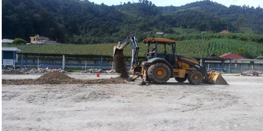
Retroexcavadora perforando zanja para drenaje tipo francés
