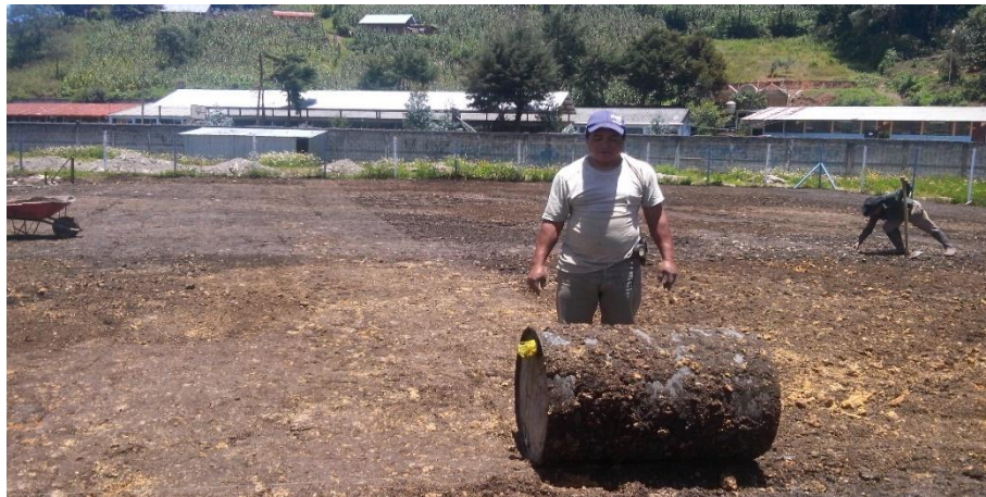
Mano de obra no calificada nivelando
