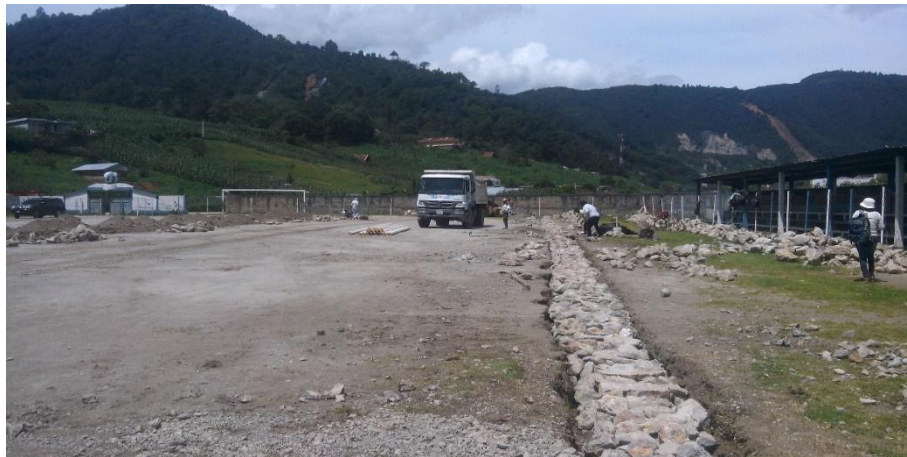
Finalización del primer drenaje tipo francés
