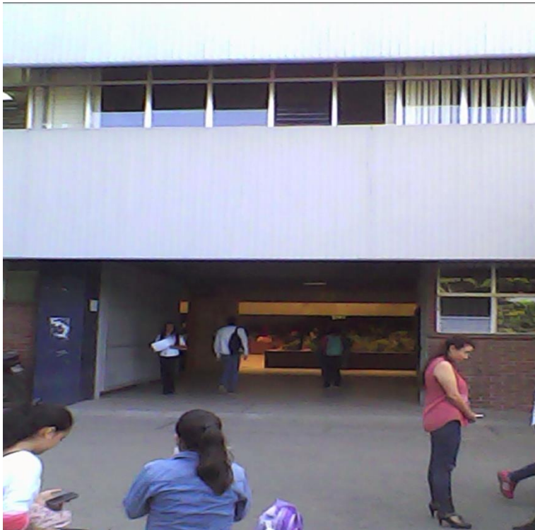
Entrada principal del edificio S12.
