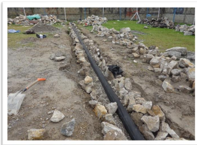
Colocación de tubos, manta geotextil y grava.
