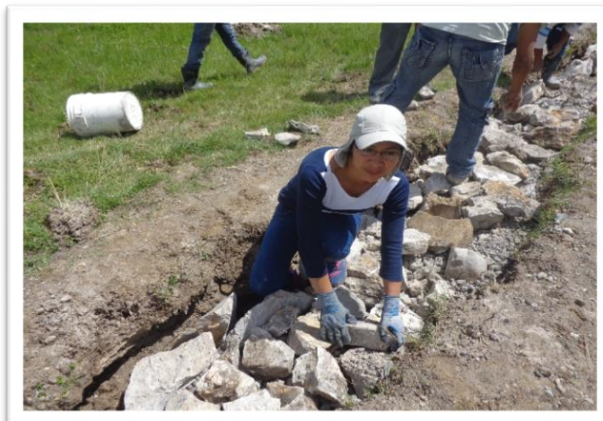
Colocando capas de piedra sobre tubos y manta geotextil.
