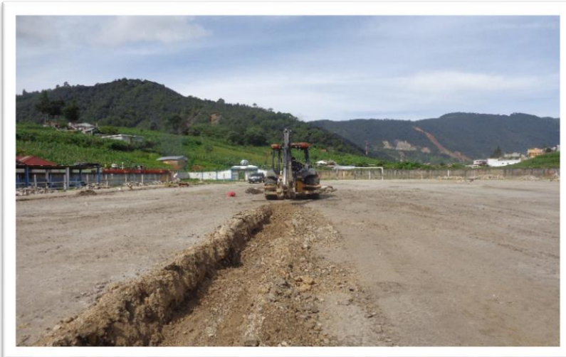
Realización de zanjas.
