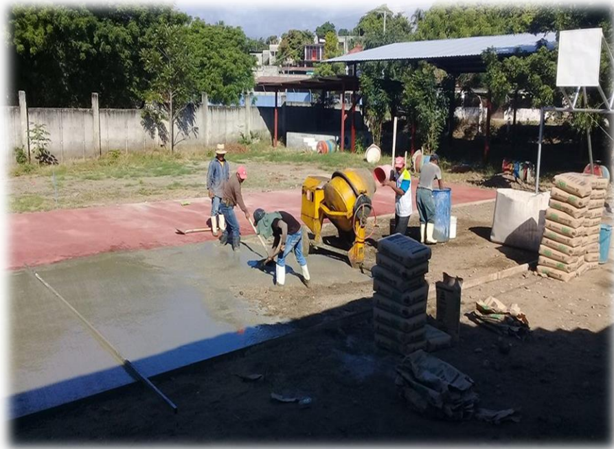
Proceso de construcción de los bloques o segmentos que constituirán el piso de la cancha polideportiva. Fotografía tomada por Jeison Duque
