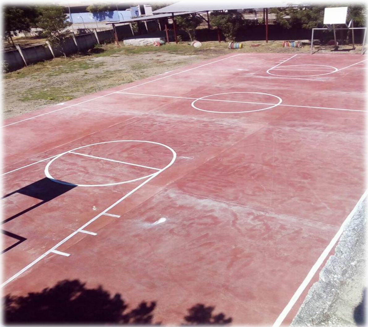
Construcción y señalización de cancha polideportiva finalizada, lista para ser entregada en el acto de inauguración. Fotografía tomada por Jeison Duque
