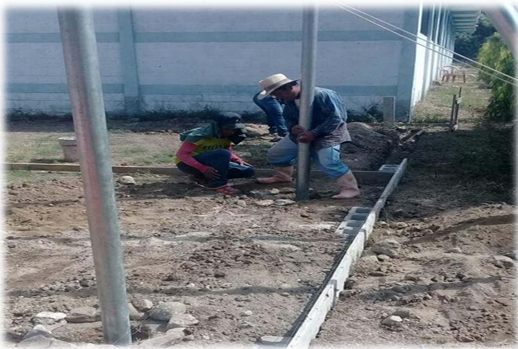
Instalación de las porterías/tableros de la cancha polideportiva de FAHUSAC, Sede Zacapa.
