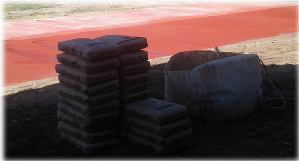
Algunos materiales de construcción para culminar el área que conformará el piso de la cancha polideportiva. Fotografía tomada por Jeison Duque
