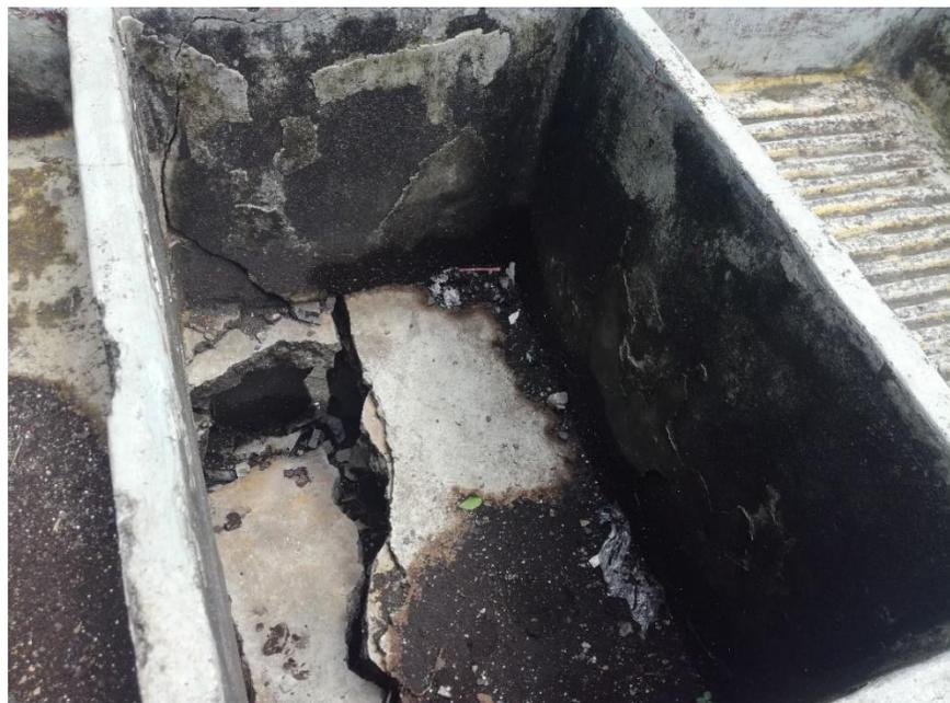
Fotografía tomada por la Epesista a la pila quebrada vista desde la parte de adentro
