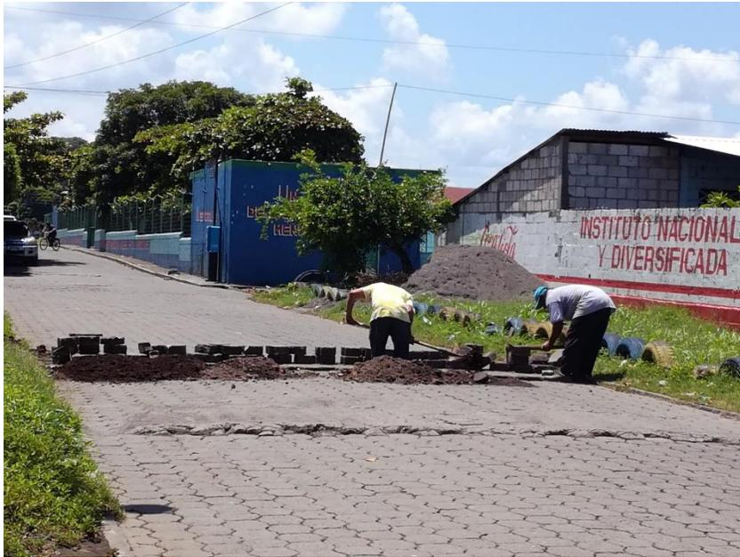
Fotografía tomada por la Epesista a los trabajadores Municipales quitando el adoquín de la calle para la instalación de Agua Potable.
