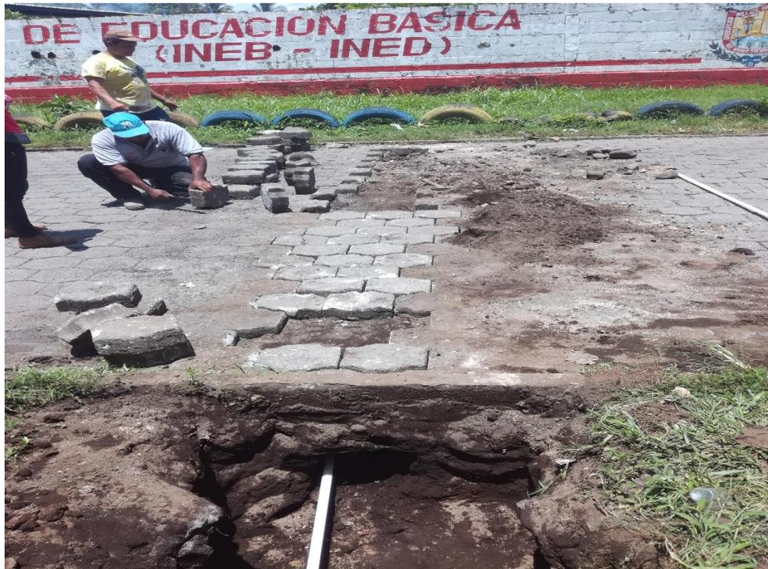
Fotografía tomada por la Epesista a la tubería ya instalada en la parte de afuera del Instituto Nacional de Educación Básica -INEB- Río Bravo, Suchitepéquez.
