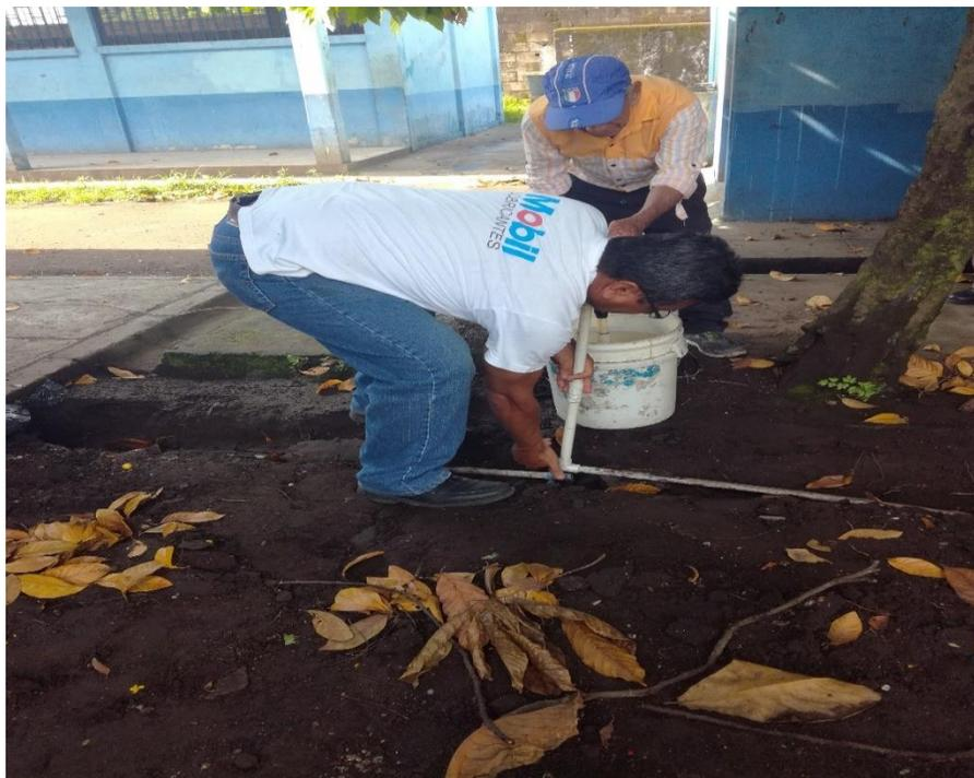
Fotografía tomada por la Epesista en la instalación de tubería en el parte de los sanitarios
