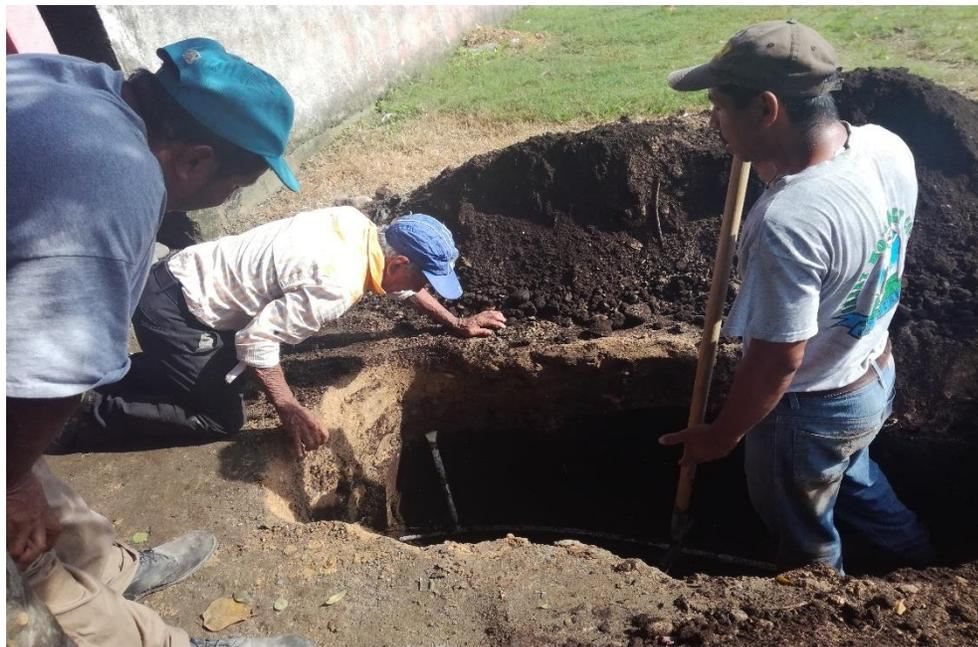
Fotografía tomada por la Epesista a los trabajadores Municipales verificando si está bien colocada la tubería de Agua Potable
