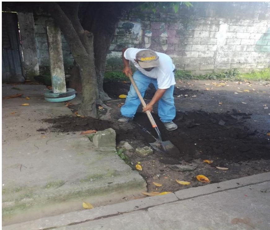
Fotografía tomada por la Epesista a trabajadores Municipales zanjeando en la parte de adentro del Instituto Nacional de Educación Básica –INEB-, Río Bravo, Suchitepéquez, para la instalación de tubería de Agua Potable para los sanitarios
