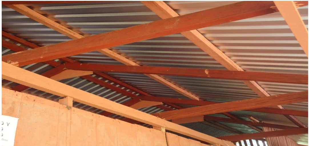
Figura 8. Cambio de techo
