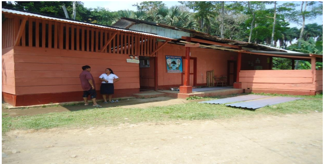
Figura6. Recepción de materiales para cambio de techo
