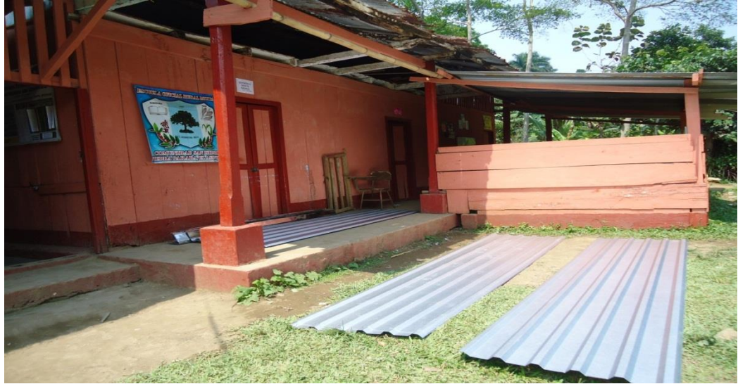
Figura 5. Recepción de materiales para cambio de techo
