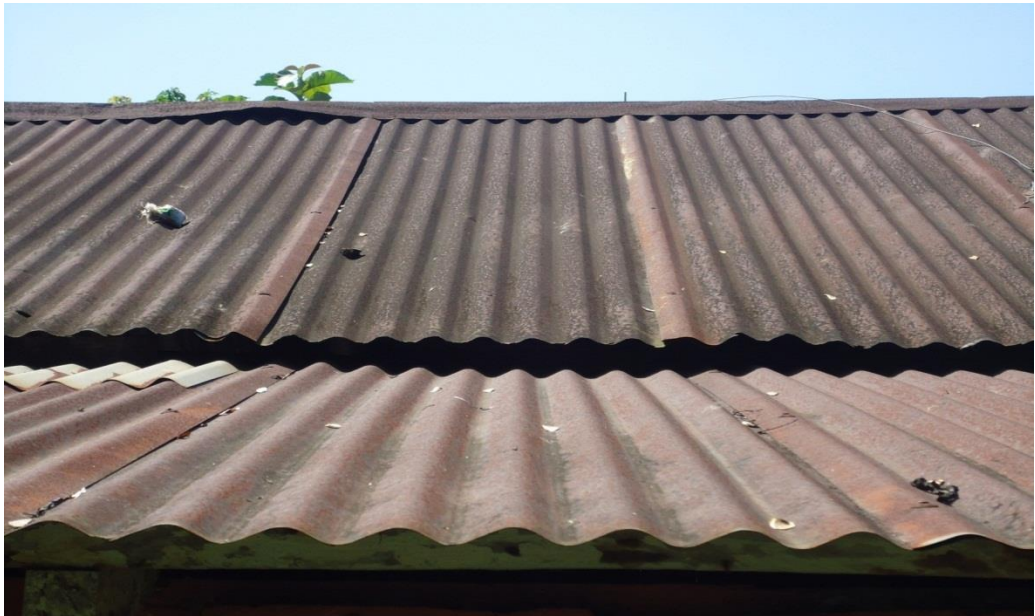
Figura4. Techado de la Escuela Oficial Rural Mixta
