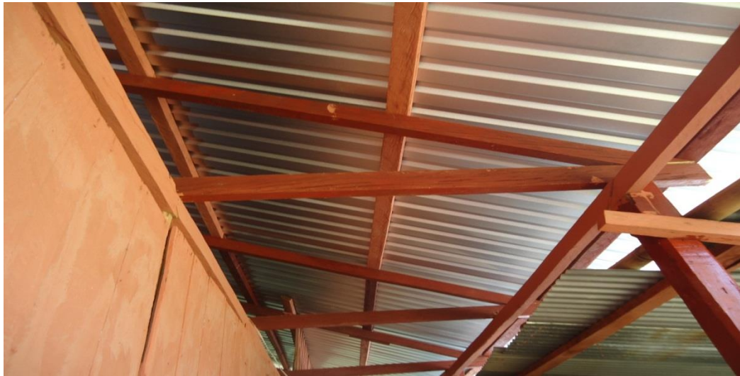
Figura 7. Cambio de techo
