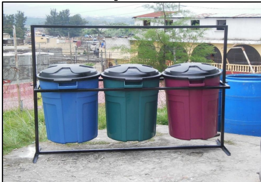
Autora: Rosa Peruch Instalación de la segunda base metálica, a un costado del segundo patio de la E.U.M. Planes de Minerva, Col. Planes de minerva, zona 11 de Mixco, Jornada Matutina (2017)
