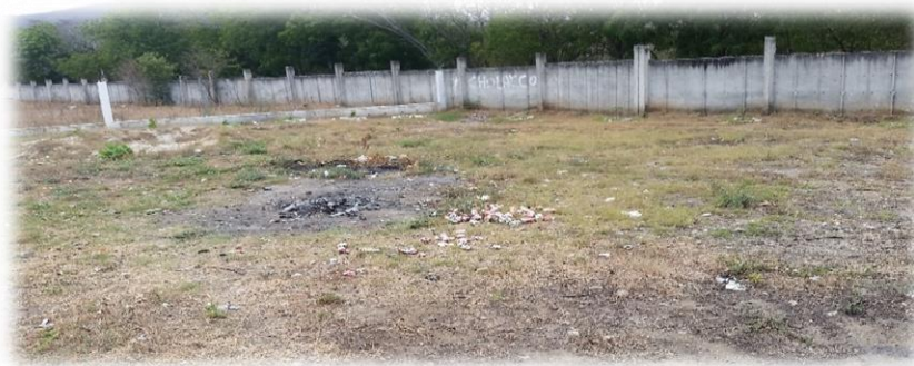
Foto 1: área antes de la construcción de la cancha polideportiva. (Fotografía tomada por Jessica Paz)
