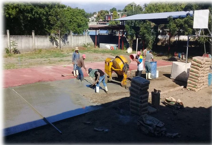
Foto 3: fundiendo la segunda fase de la cancha, para el proyecto de acondicionamiento deportivo para el uso del estudiantado de la Fahusac, Zacapa. ( Fotografía tomada por Jeison Duque )
