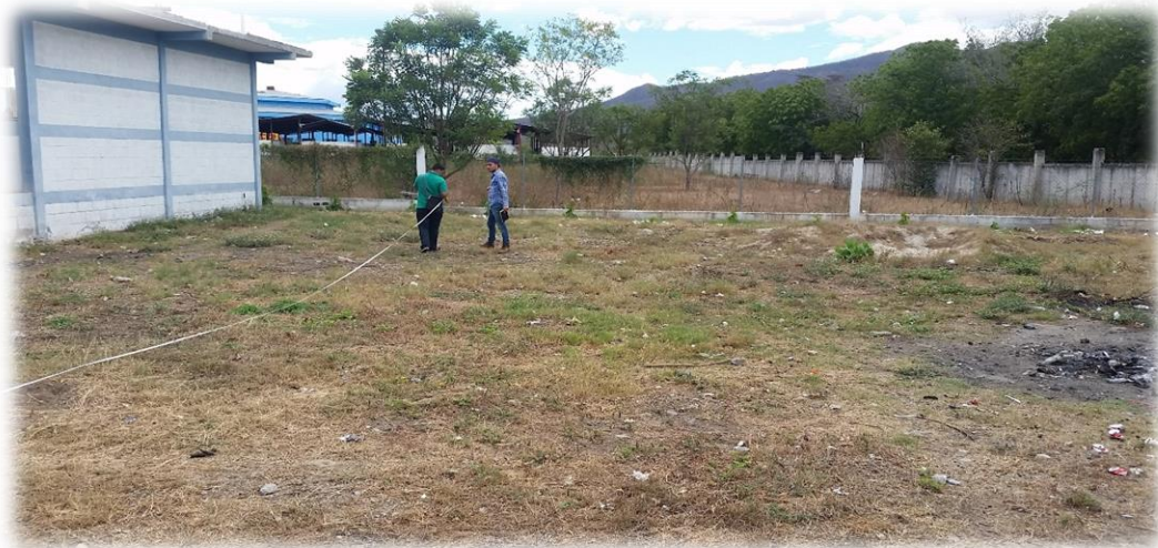
Foto 2: Realizando las medidas para el proyecto de acondicionamiento deportivo para el uso estudiantado de la Fahusac, Zacapa. ( Fotografía tomada por Jessica Paz )
