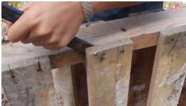
3. Desmontar dos reglas del lado inferior de la parte que servirá para el asiento. (la parte que mide 50 centímetros de alto)
