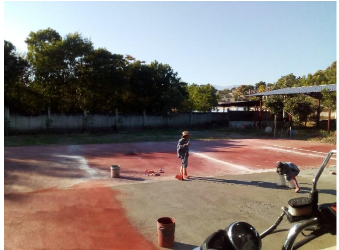
Fotografía tomada por: Dulce Orellana Proceso de construcción de la cancha polideportiva
