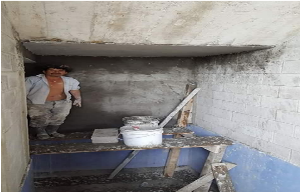
Acabados del segundo y tercer nivel
