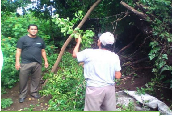
Limpeza del área donde se instaló la fosa séptica, para el uso de las aguas residuales.
