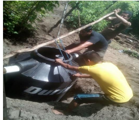
Colocando la fosa séptica con las medidas y el nivel respectivo para garantizar su función.
