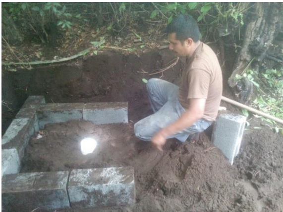
El pastor evangélico Yobani Polanco apoyando el proyecto y anivelando para la instalación de la tasa de sanitario.
