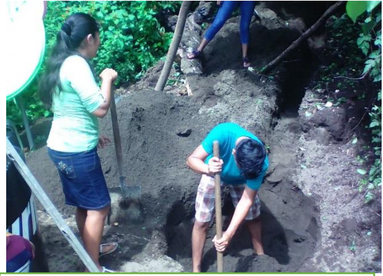
Jóvenes voluntarios excavando para la instalación de la fosa.
