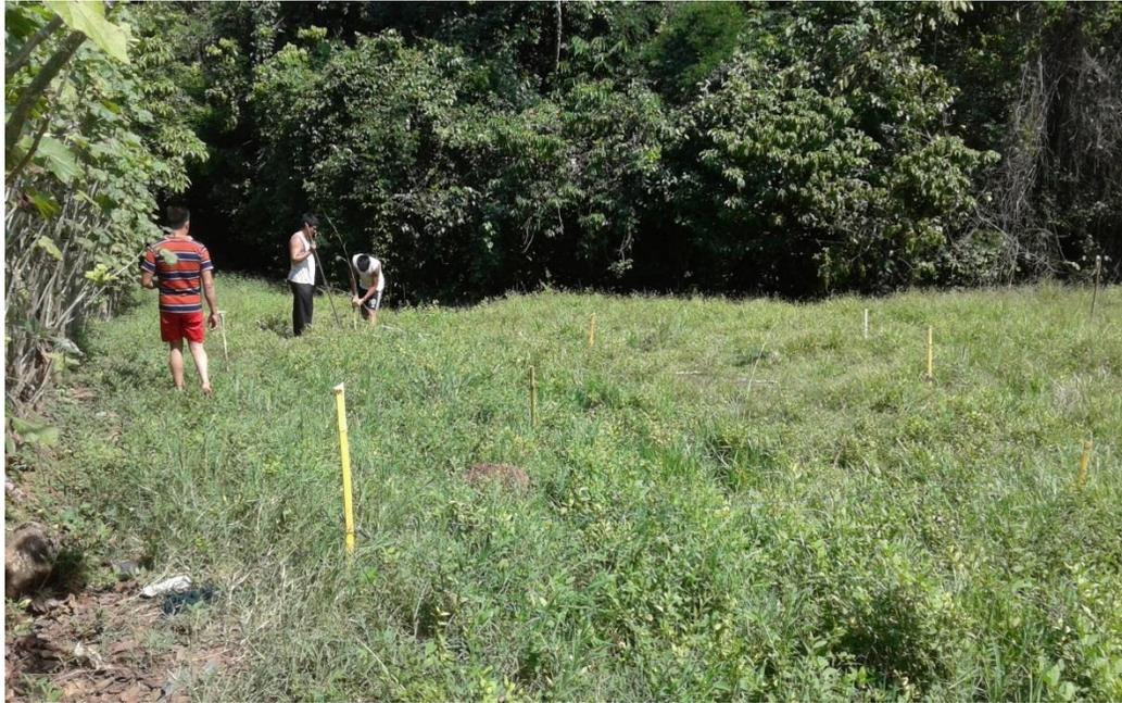
P.F.: Foto tomada por el epesista en donde se está realizando la medición y estaqueo del terreno.
