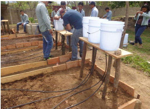
Fotografías 11, 12, instalación de sistema de riego por goteo, fotografías captadas por Gabriela Raxcacó EPESISTA coordinadora del proyecto
