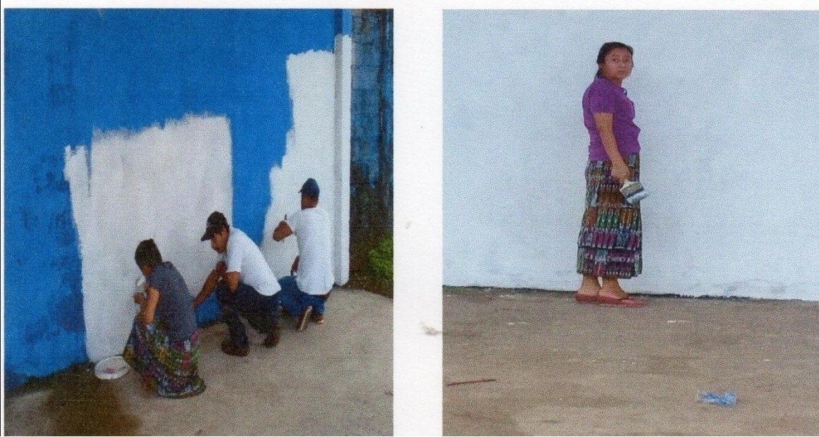
P.F. Foto tomada por la epesista. Epesista y pintores durante el Proyecto de Remozamiento de la Pared del Escenario de EORM "El Quetzal".
