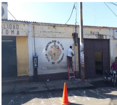
Ilustración 73 fotografía tomada por epesista, mantenimiento de pintura al edificio municipal
