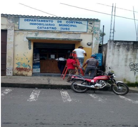
Ilustración 72 fotografía tomada por epesista, mantenimiento de pintura al edificio municipal
