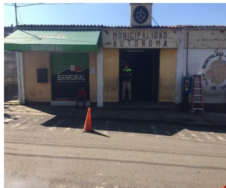
Ilustración 69 fotografía tomada por epesista, mantenimiento de pintura al edificio municipal
