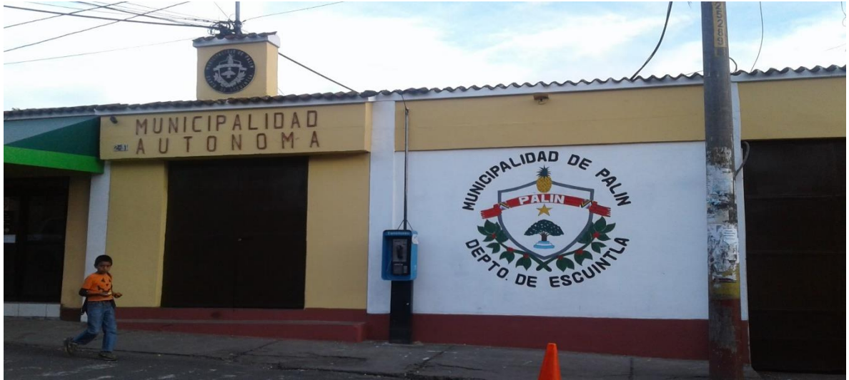
Ilustración 74 fotografía tomada por epeista, mantenimiento de pintura al edificio municipal
