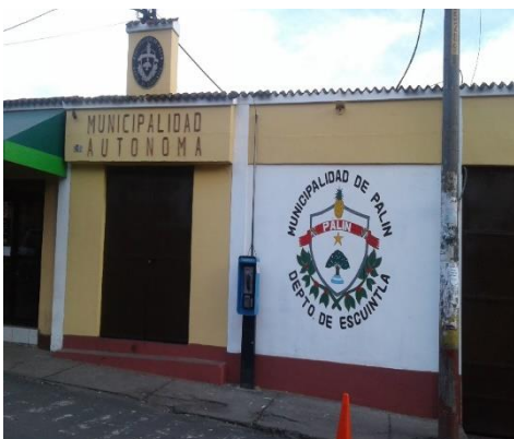
Ilustración 70 fotografía tomada por epesista, mantenimiento de pintura al edificio municipal
