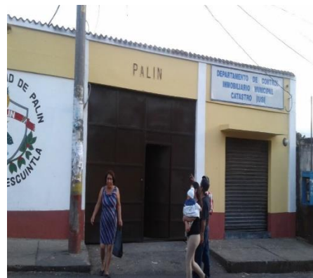
Ilustración 71 fotografía tomada por epesista, mantenimiento de pintura al edificio municipal
