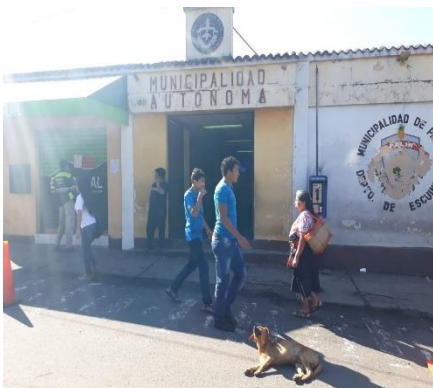
Ilustración 68 fotografía tomada por epesista, mantenimiento de pintura al edificio municipal
