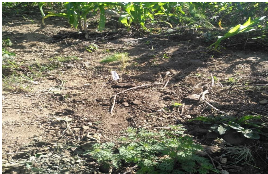
Foto 8: área para realizar limpieza e iniciar la perforación para la plantación.
