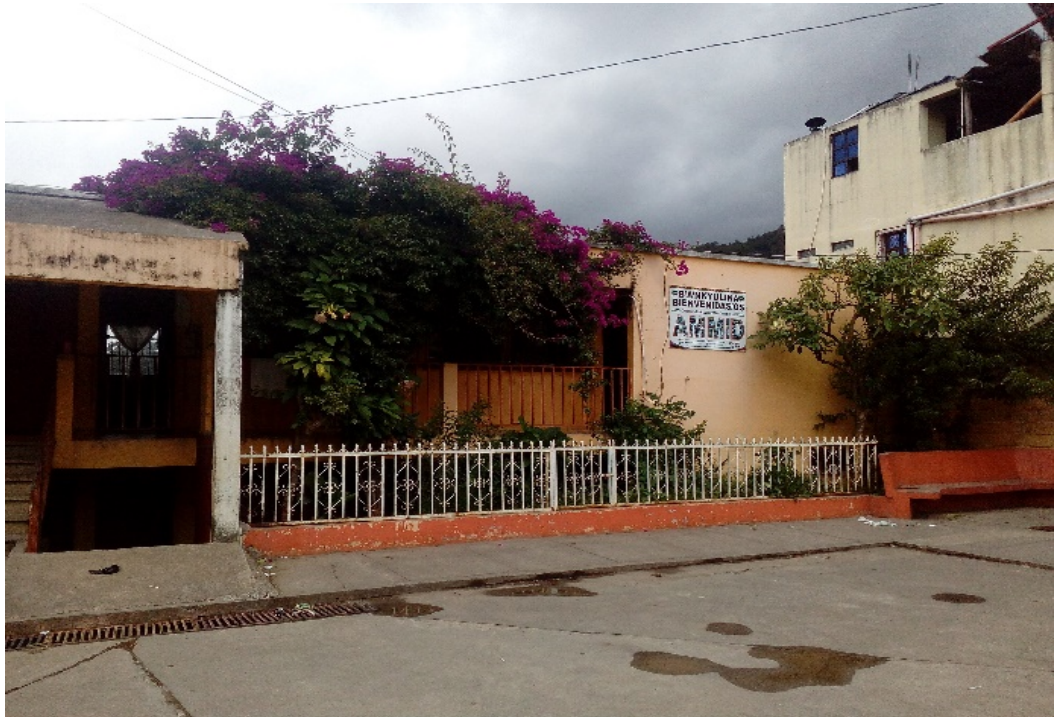
Fotografía del edificio de las coordinaciones técnicas administrativas de los distintos sectores.
