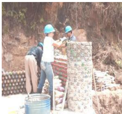
Figura 33. Ejemplo de cómo apilar los “ladrillos plásticos” para levantar un muro con los mismos
