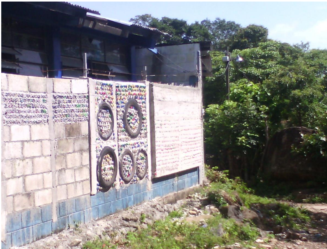
Figuras 13 y 14. Documentación fotográfica del proyecto terminado: se aprecia que, luego de terminado el muro, ya no se tiene acceso visual a las aulas.
