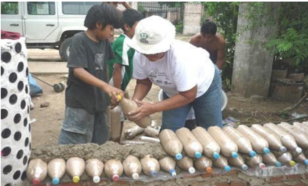
Figura 34. Iniciando la apilación de los “ladrillos de plástico”
