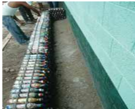
Figura 30. Avances del muro con material reciclable
