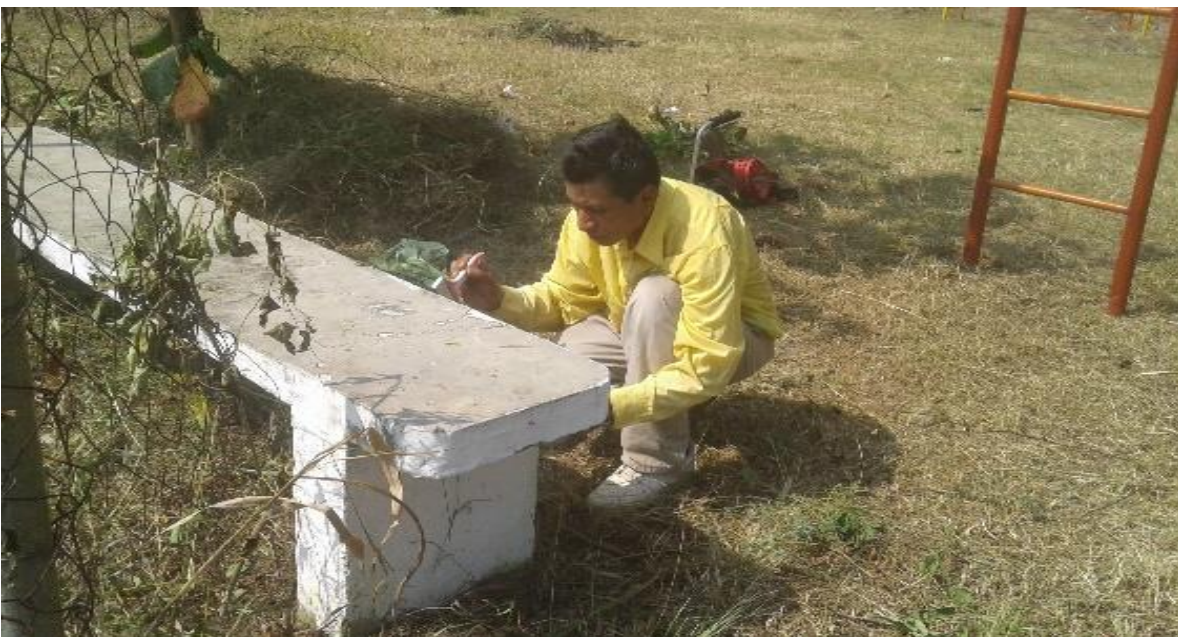
Trabajos finalizados en el chapeo y encalado de bancas.
