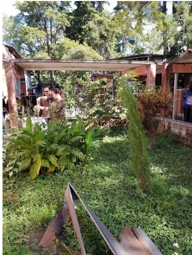
Figura 19: Entonces procedimos a realizar agujeros con barreno para evitar que se acumulara agua en el fondo (Fuentes, Gudiel, Ortíz, & Rodas, 2017).
