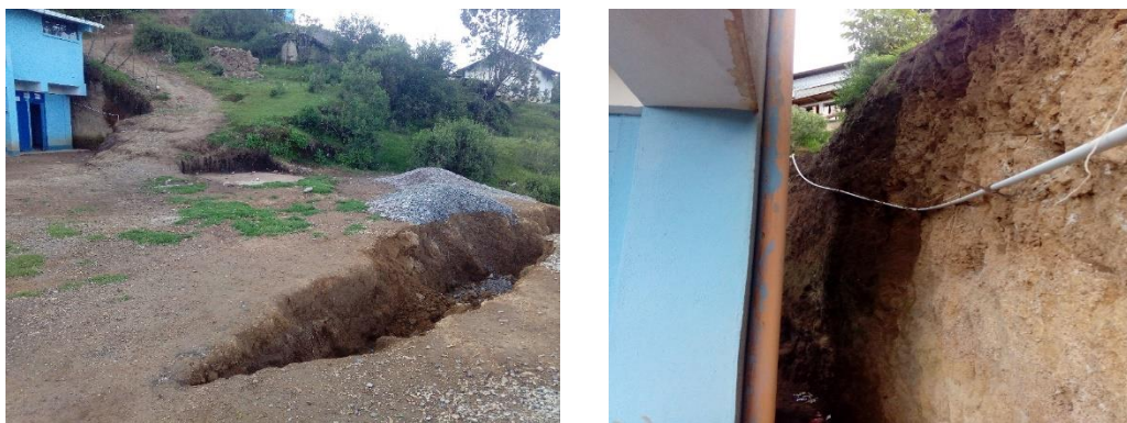
Fotografías tomadas del edificio escolar
