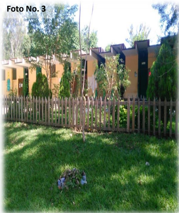
Limpieza del área para pintar
