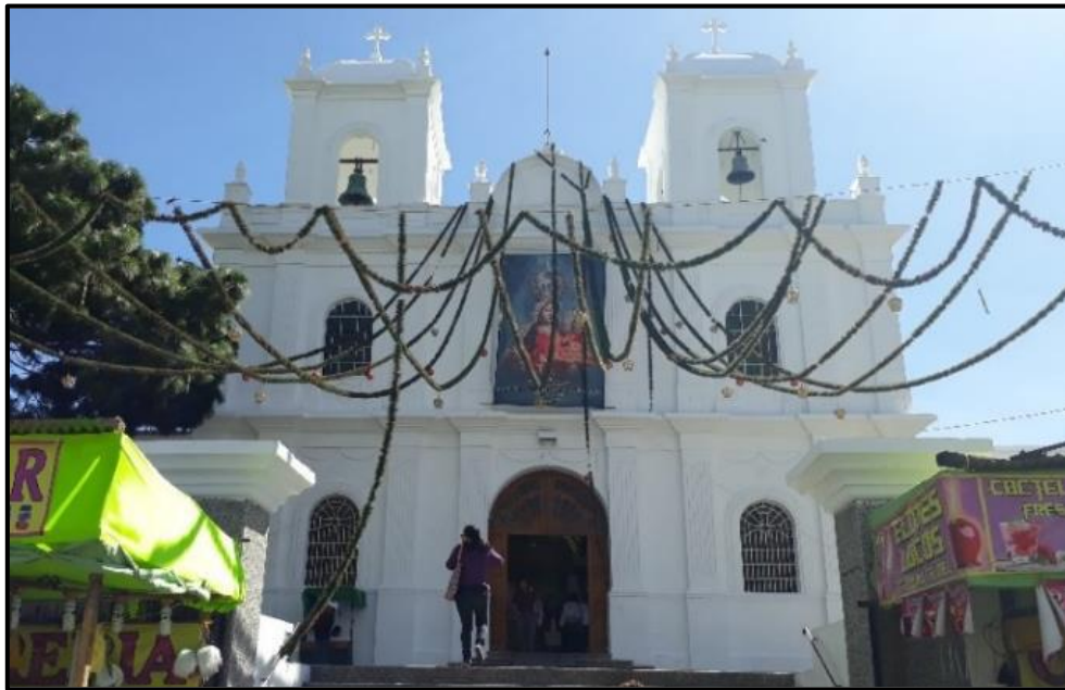
Foto No. 9. Iglesia de Mixco en el 2018. Abril 2018.
