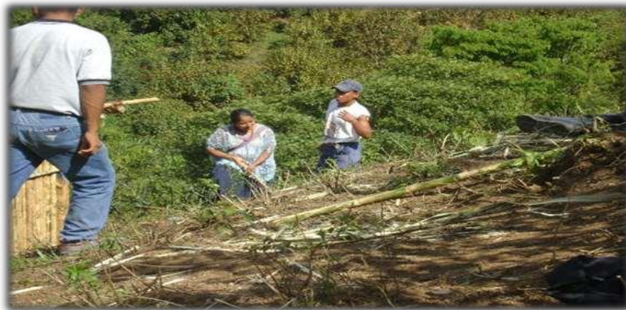
Personas levantando los escombros después del deslave en Barrio el Calvario, municipio de Senahú, A.V. 69
