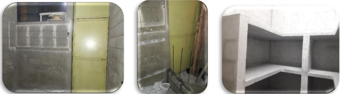
Construcción de las estanterías para colocar alimentos de refacción escolar
