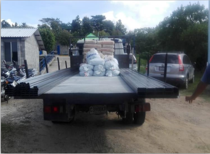
Fotografía No. 5 descarga de material para construcción
