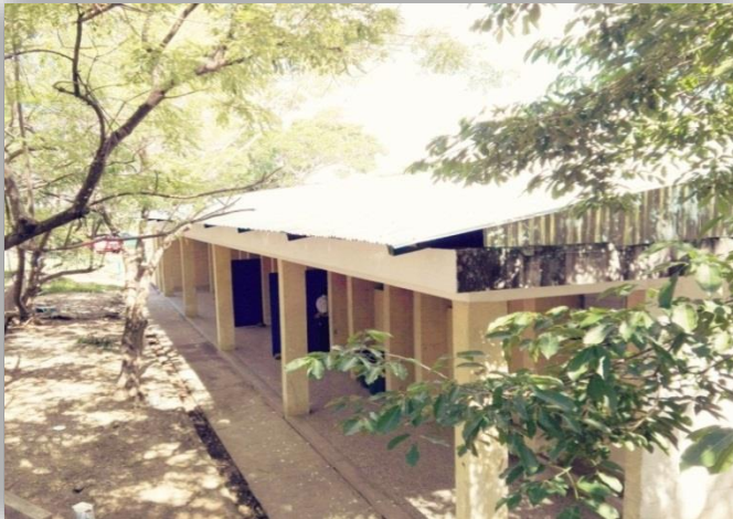
Fotografía No. 7 lado izquierdo del techo construido
