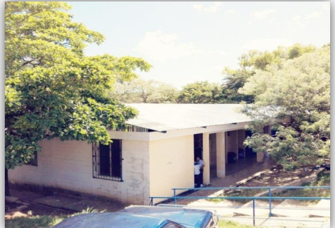
Fotografía No. 8 lado derecho del techo construido
