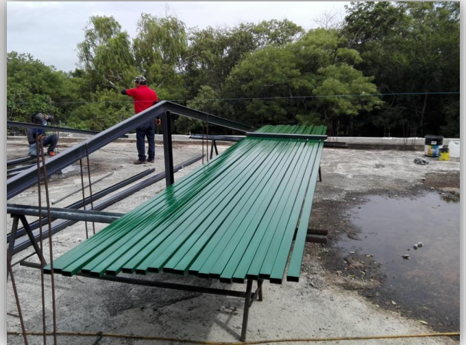
Fotografía No. 6 construcción del techo del módulo 3
