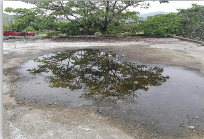
Fotografía No. 2 condiciones afuera del techo del módulo 3
