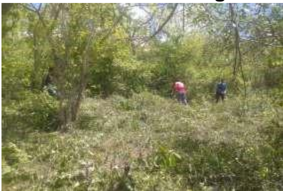
Foto 13 Captada por Epesista. Limpieza del terreno: eliminación de la maleza del lugar antes de sembrar
