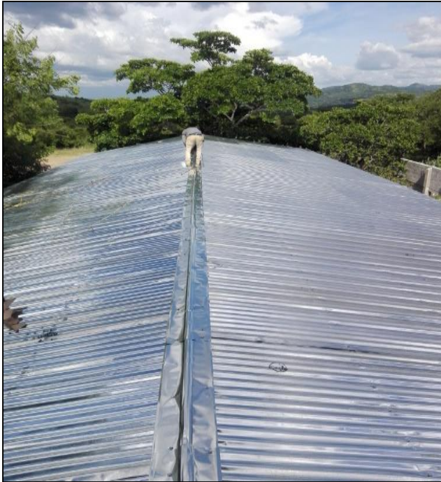
Elaboración de sobre techo del módulo tres
