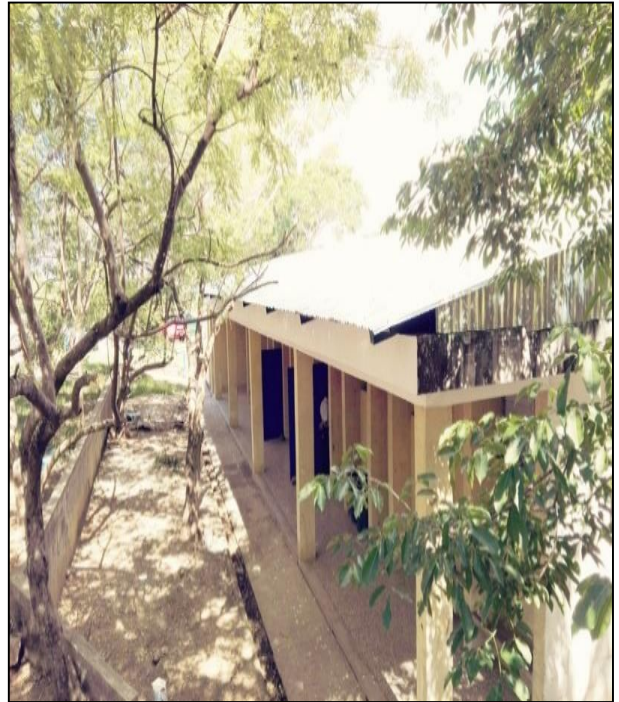
Techo del módulo tres (Después)
