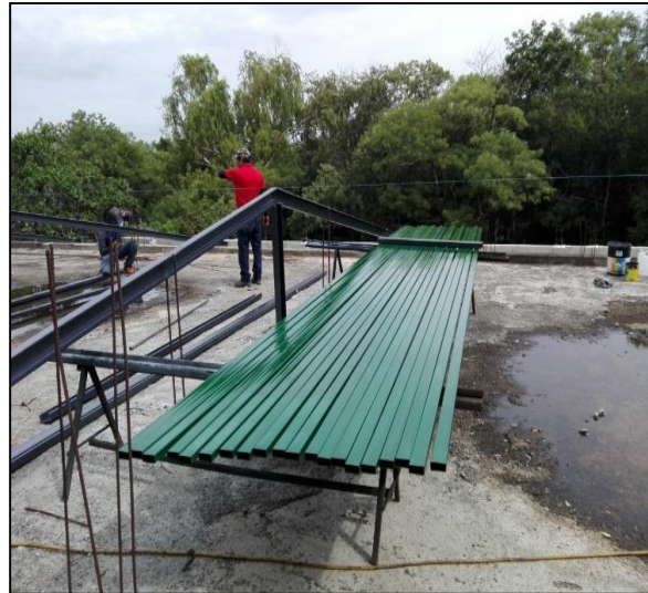
Elaboración de sobre techo del módulo
