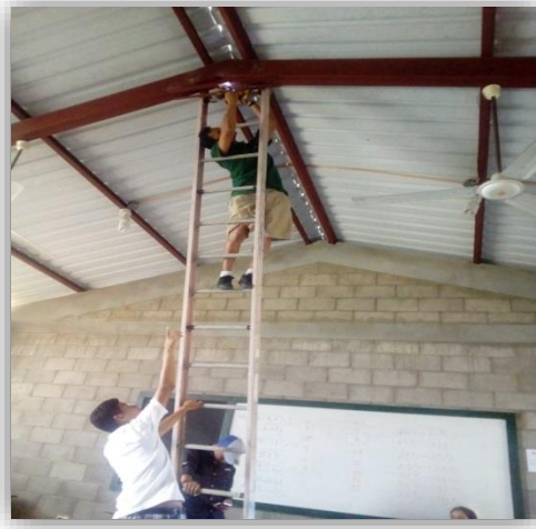
Instalación de soporte de techo para los proyectores.
