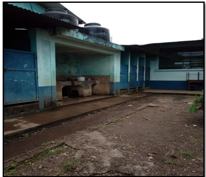
Foto No. 7 BAÑOS DEL INEB
