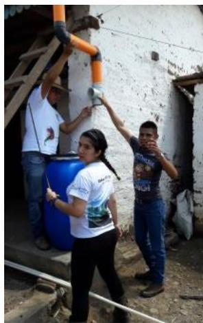
En la fotografía se observa a los estudiantes de la Facultad de Humanidades, Plan Domingo y de EPSOM colocando las uniones de las tuberías para la captación de agua pluvial.
