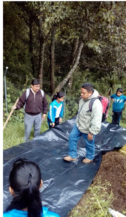
Ingeniero de la municipalidad de Sololá brindando asesoría técnica para la construcción de la abonera
