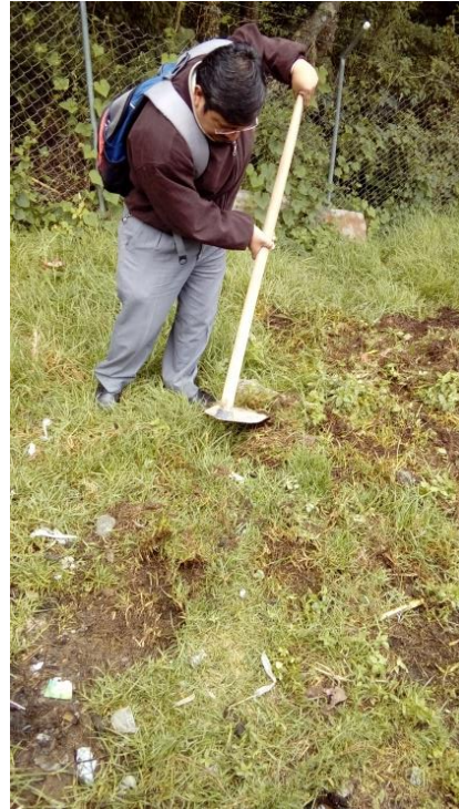
Foto tomada por: Amelia Saloj Bocel Descripción: en la imagen se observa al Epesista limpiando el área para la construcción de la abonera
